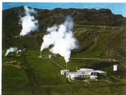
Central geomètrica (Islàndia)
