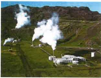
Central geotèrmica (Islàndia)
